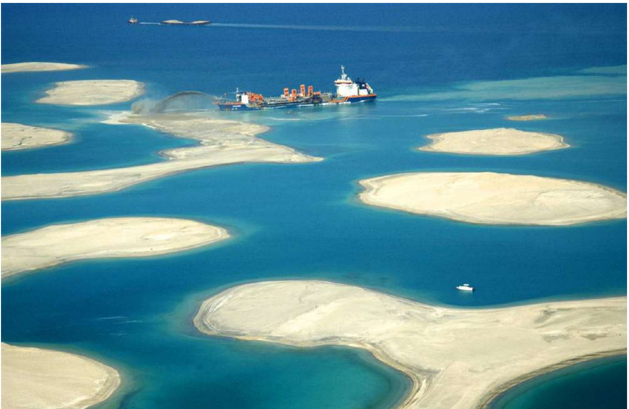
Un dels vaixells durant el trasllat de sorra en la construcció de Dubai World, el 2004
